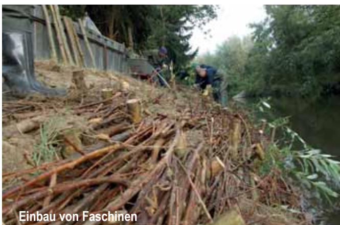
Einbau von Strömungslenkern am Oetternbach bei Lage
