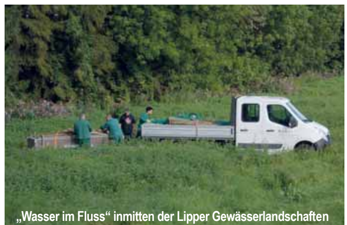
Anfertigung von Steckhölzern zur Befestigung von Faschinen
